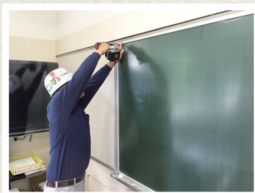
3. 元の枠や粉受けはそのまま再利用し、 新たに四方アルミ枠を取り付ける
