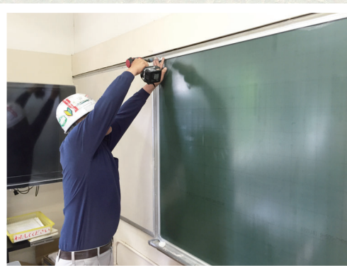
3. 元の枠や粉受けはそのまま再利用し、 新たに四方アルミ枠を取り付ける
